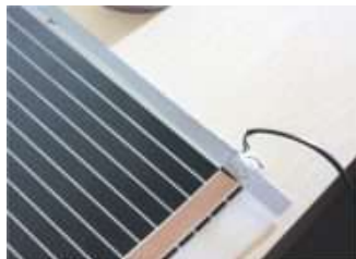
6. Izolacja połączeń zasilających.
