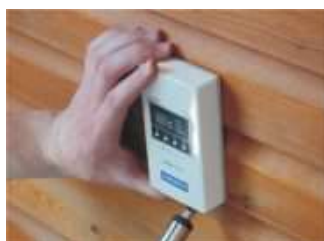
11. Instalacja termostatu.
