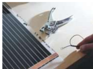
4. Wycięcie otworów instalacyjnych przy pomocy nitownicy.
