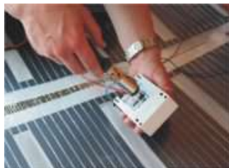
7. Podłączenie termostatu.
