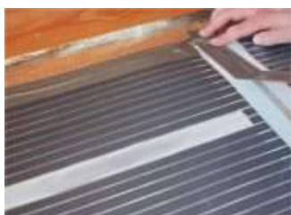
9. Przymocowanie maty do podłoża.
