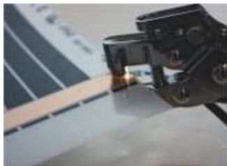
5. Podłączenie przewodów zasilających.
