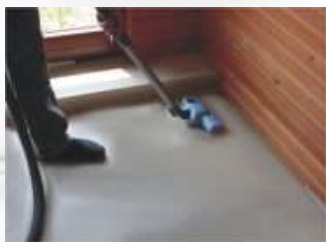
1. Oczyszczenie powierzchni podłogi.
